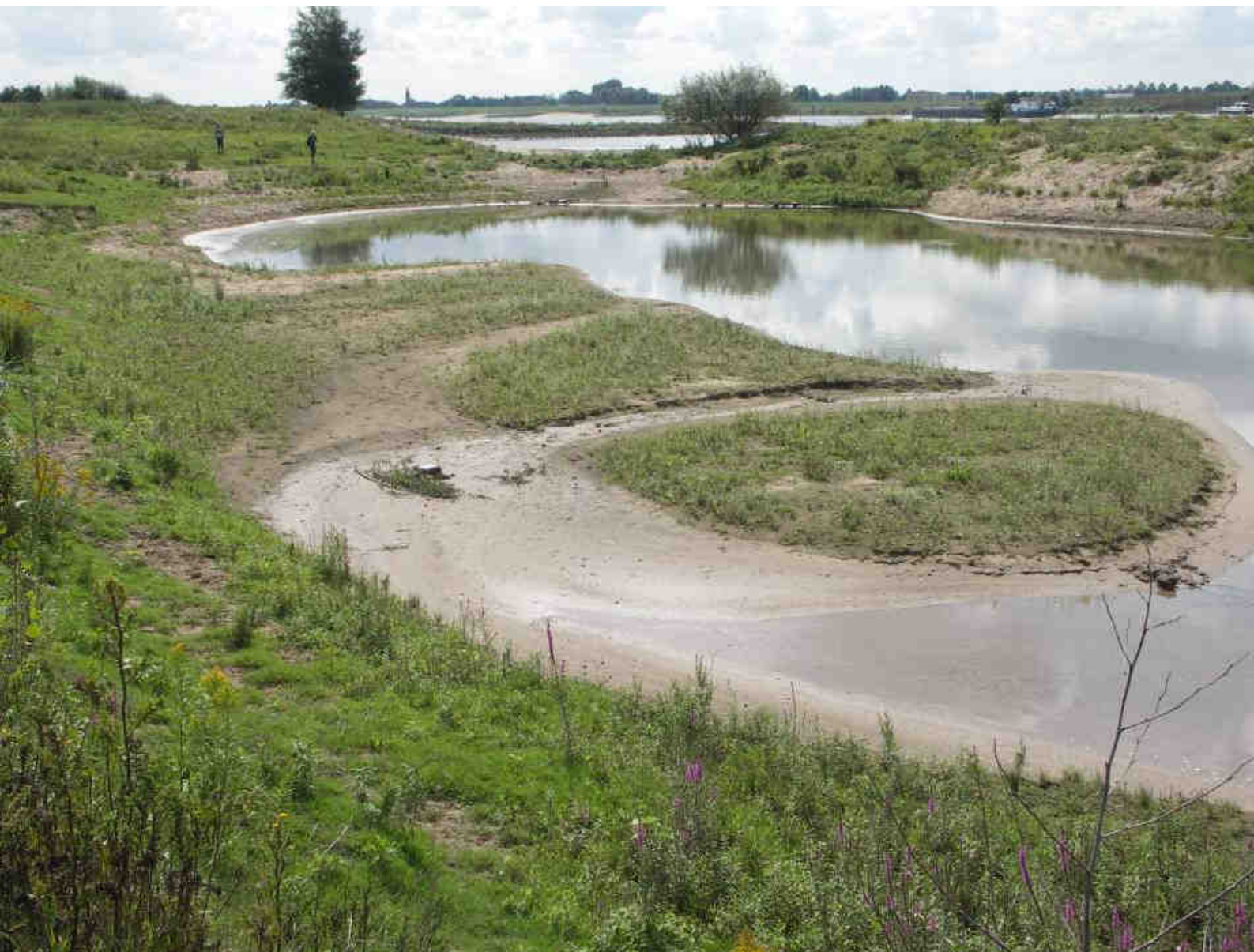
De instroom van de hoogwatergeul in de Klompenwaard met een drempel uit breuksteen en lokale zandafzettingen en kolkgeden.
