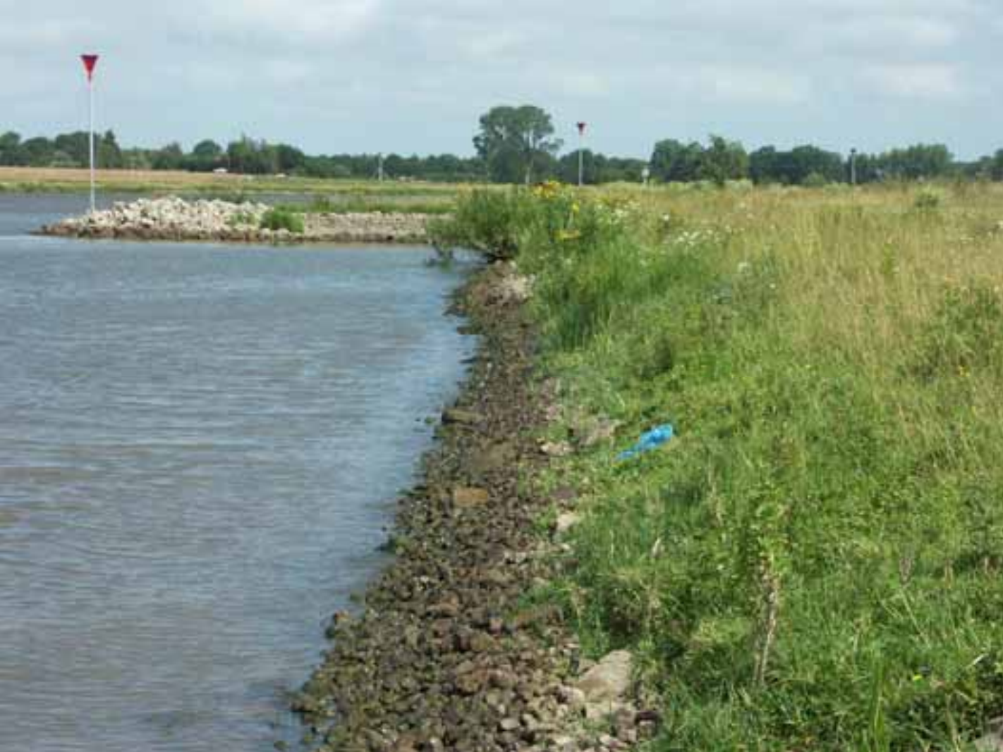
De IJsseloeveren liggen bij de Vreugderijkerwaard volledig in de stortsteen. Dit beperkt de beschikbaarheid van zand voor oeverwalvorming tijdens hoogwaters.
