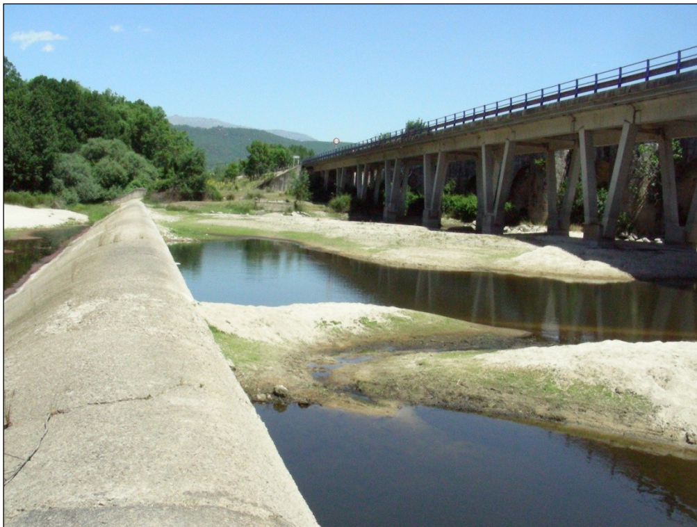
Vista del azud desde la margen izquierda
