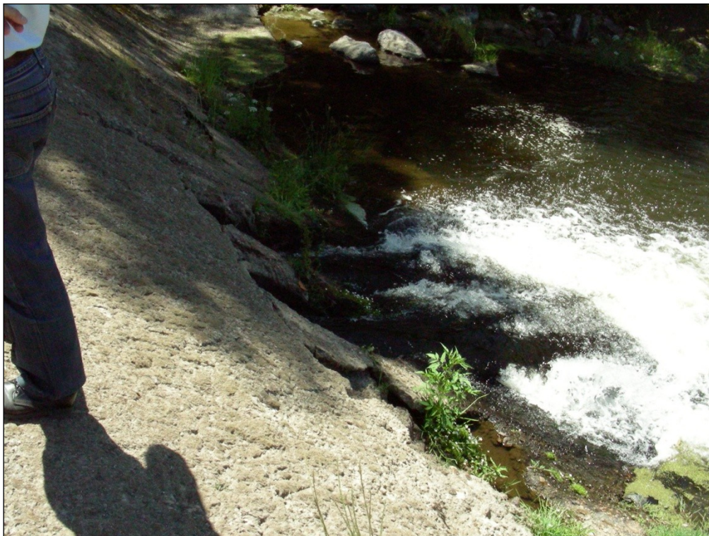
Detalle de los desagües de fondo
