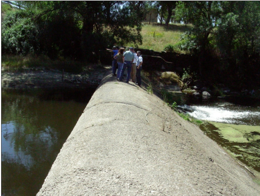
Vista de la margen izquierda y detalle del azud
